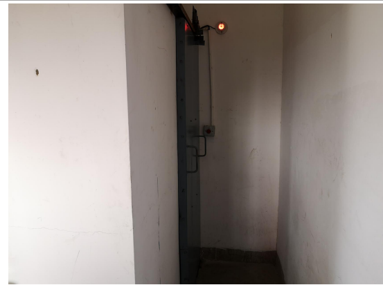
操作人员进出防护门
